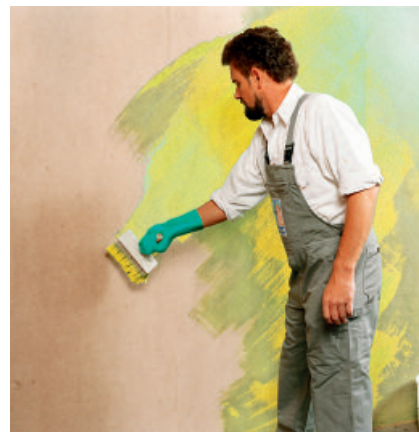
PCI Wadian als Wasserdampf bremsende Grundierung auf Holzspanplatten vor der Fliesenverlegung.
