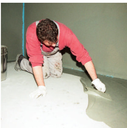
4. ... oder der zementären Sicherheits-Dichtschlämme PCI Seccoral
