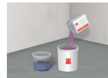
8 Verdünnen von ASO-Unigrund-S mit Wasser 1:1
