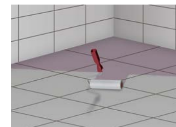
4 Gleichmäßiges verteilen von ASO-Unigrund-S mit einer Lammfellrolle
