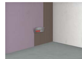
10 Aufkämmen z. B. eines Klebemörtels
