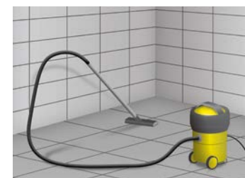
1 Reinigen des Untergrundes
