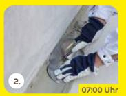
Der schnellabbindende, wasserundurchlässige Kehlmörtel weber.tec 933 wird nach Vorschlämmen der Haftbrücke aufgebracht und sofort ausgerundet. Damit wird eine gleichmäßige Schichtdicke der Dickbeschichtung erreicht.
