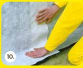
Nach Durchtrocknung der Abdichtung erfolgt das Aufbringen des Abdichtungsschutzes weber.sys 983 kombinierte Schutz- und Dränagematte. Die Matte wird oberhalb der Abdichtung fixiert und im unteren Bereich an die Ringdränage herangeführt. Danach wird die Baugrube angefüllt.
