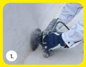
Der Untergrund muss frei sein von Schmutz, wasserabweisenden, haftungsmindernden Bestandteilen. Die Außenkante des Fundamentvorsprungs muss gebrochen werden.
