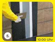
Gebäudetrennfugen werden abgedich- Durchdringungen (z. B. Abwassertet mit weber.tec Superflex B 240 E, vlieskaschiertes Abdichtband. Die Bänder werden auf der Wand verklebt und durchführungssystem (z.B. Doyma) in mit der Abdichtung im Randbereich übersoachtelt.
