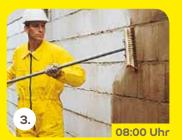
Grundierung mit weber.tec 901, 1:10 RT mit Wasser verdünnt, zur Staubbindung und Herstellung eines gleichmäßig saugfähigen Untergrundes.
