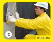
Auftrag der ersten Abdichtungslage webertec Superflex 2K mittels Schichtdickenkelle. Die Auftragsdicke hängt von der Wasserbelastung ab. Bei Abdichtungen gegen Druckwasser wird frisch in frisch die Verstärkungseinlage weber.sys 981 eingearbeitet.
