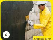
Nach Trocknung der Grundierung erfolat zunächst eine Kratz- und Füllspachtelung mit der Bitumendickbeschichtung webertec Superflex 2K.
