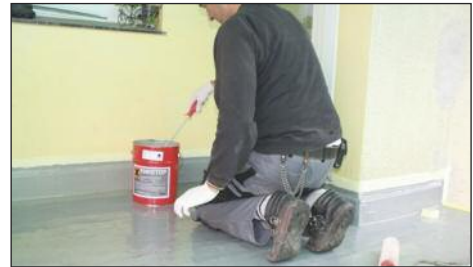
Aufgehende Wandanschlüsse mit ENKETOP streichen
