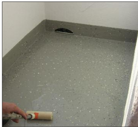
Auftrag der ENKETOP-Versiegelung mit der Veloursrolle
