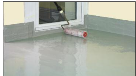
Entlüften der ENKETOP - Beschichtung mit der Stachelwalze
