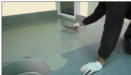
Gleichmäßiger Auftrag von ENKETOP mit der Zahnkelle
