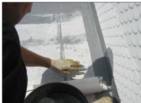
ENKOPUR Abdichtung mit vollflächiger Enke-Polyflexvlieseinlage
