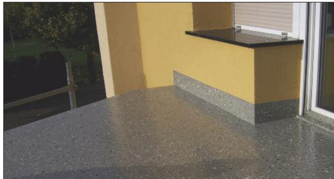
Partielle Abstreuerung mit ENKE - Kunststoffchips
