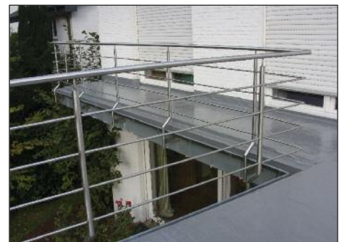
Abdichtung der Anschlüsse und der Fläche mit ENKOPUR
