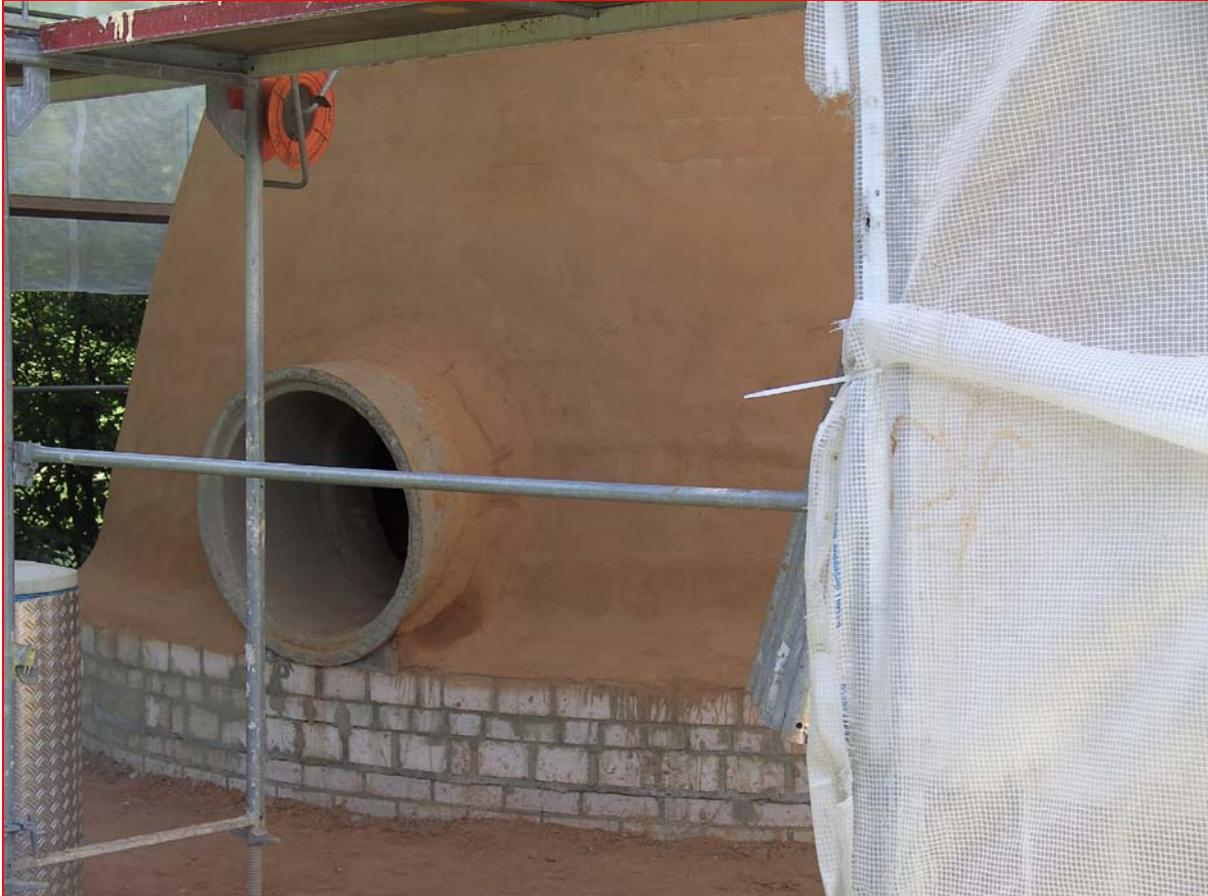
Nach einem Rückzieher der Steinmosaikleute favorisierte der Auftraggeber auch das Aufbringen eines Putzes auf unser Enkepren – Abdichtungssystem. Diese Lösung schied jedoch wegen des hohen Eigengewichtes aus.
