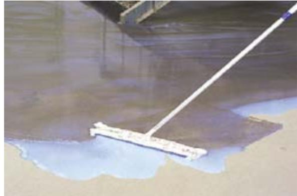
Mischung wird das Material unter Rühren mittels Bohrmaschine und Quirl im Verhältnis 1:2 nach Masseanteilen mit Leitungswasser verdünnt.
